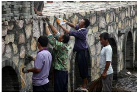
村民们正在建造七孔桥
